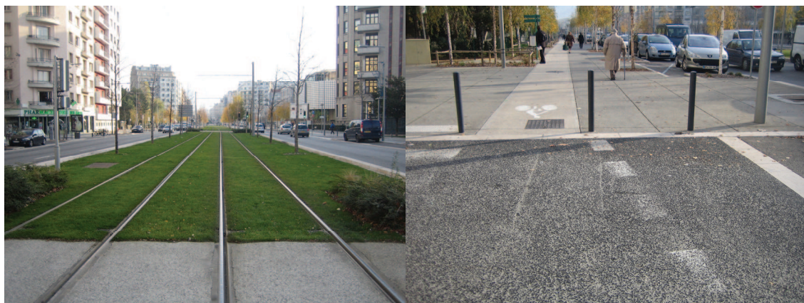
Étanchéification et canalisation des flux (photos RT)
